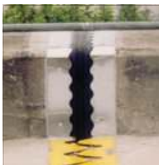
c. 설치 전경(내측)
